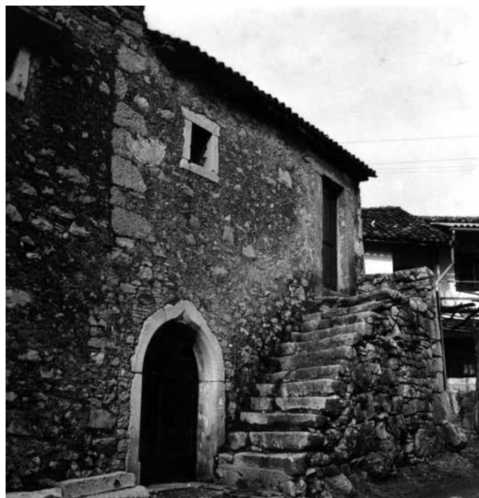
Slika 3: Domačija Dutovlje 85. Minav hram s šilasto obokano kalono v pritlični prostor, ki ima na "ajdovo zrno" porezane robove in zaključek "na oslovski hrbet", na posnetku iz 1978. leta z izvornim ometom. Do kamre v nadstropju so vodile zidane masivne kamnite stopnice. Fotodokumentacija ZVKDS, OE Nova Gorica.
