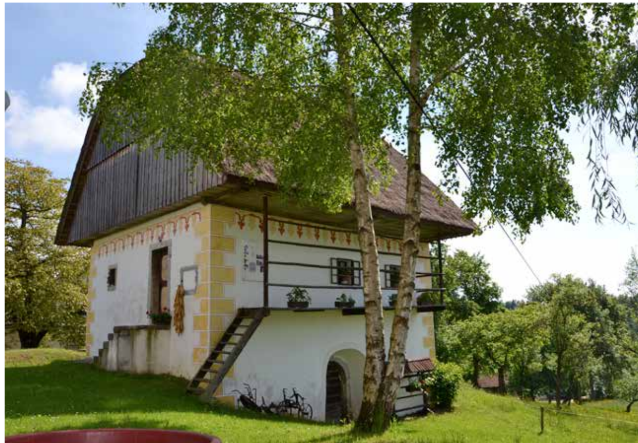
VZORČEN PRIMER KONSERVATORSKE OBNOVE ORIGINALNE FASADE Z APNENIMI OMETI je bajtarsko stanovanje v Zavratcu, t. i. Možinotova kašča. (Ščukovt, 2003)
