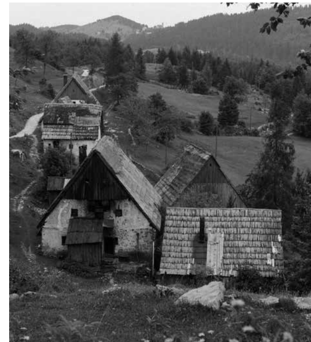
STRME STREŠNE NAKLONE SO V PRETEKLOSTI POKRIVALI SLAMA, DESKE, SKODLE ALI PLOČEVINA, odvisno od razpoložljivosti materiala.
