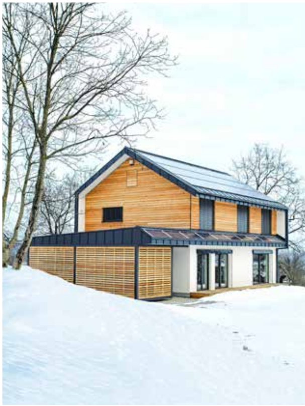
PASIVNA HIŠA iz lesa s sončno elektrarno na strehi, lg pri Ljubljani.
