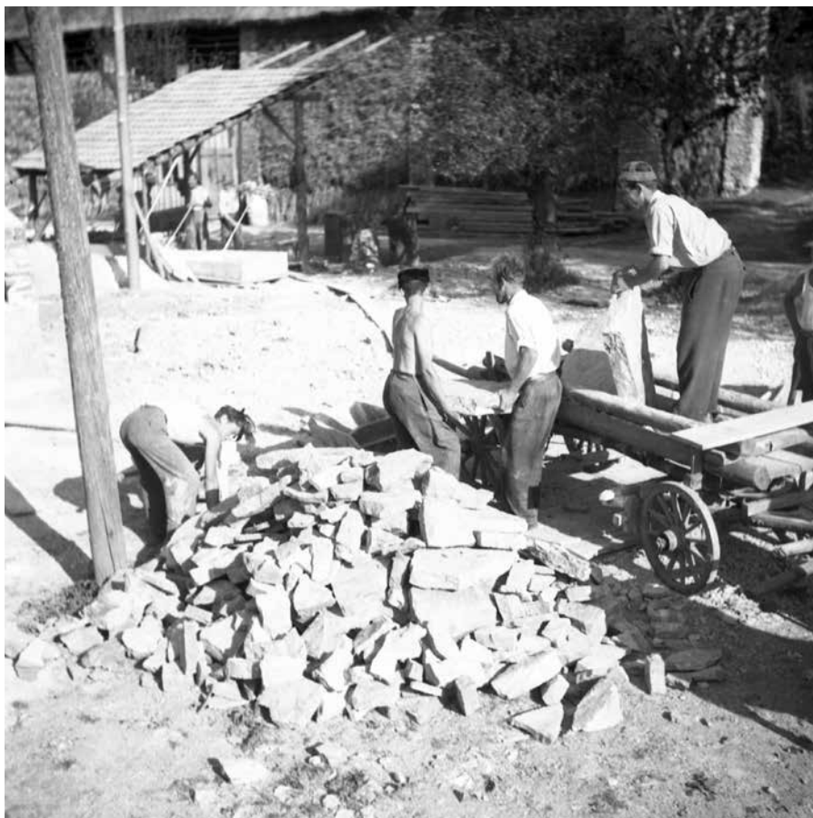
DOVOZ KAMENJA NA GRADBIŠČE OSNOVNE ŠOLE NA PEČINAH, 1954.
