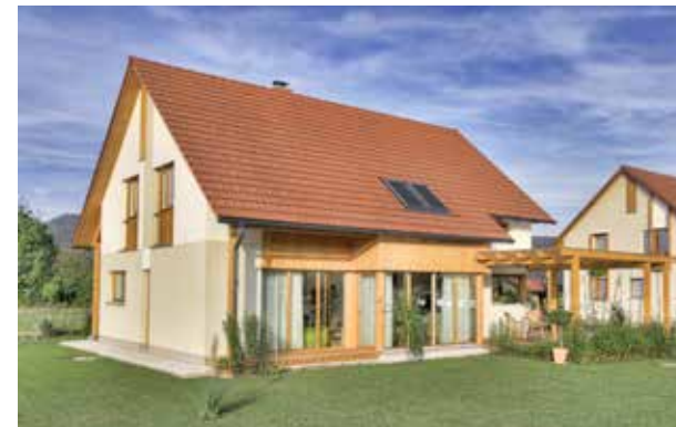
ZELO DOBRA NIZKOENERGIJSKA HIŠA IZ LESA, potrebna energija za ogrevanje je 25 kWh/(m 2 a).
