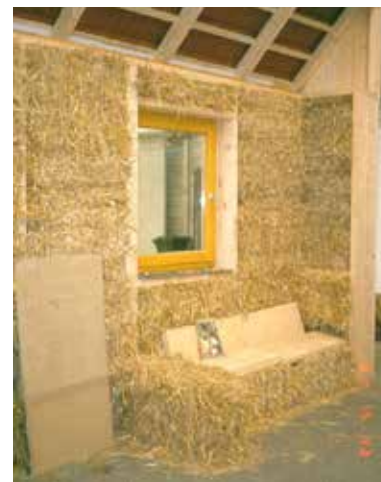
TOPLOTNA IZOLACIJA iz bal slame.
