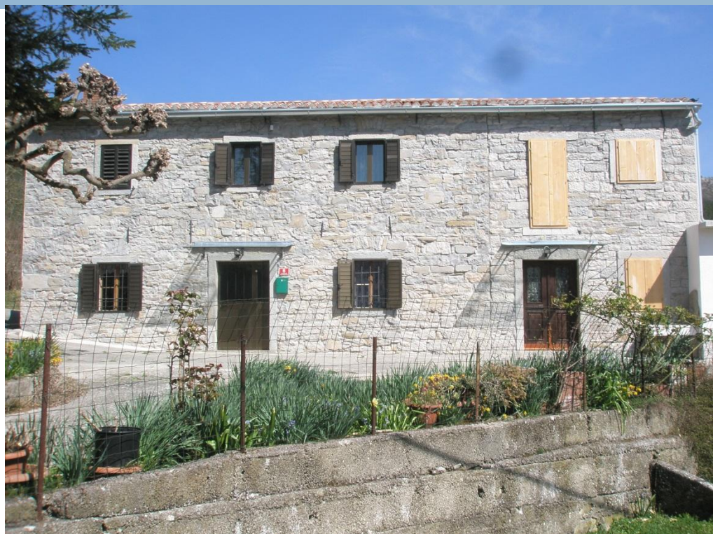
Fugirano pročelje hiše Pisari 6
